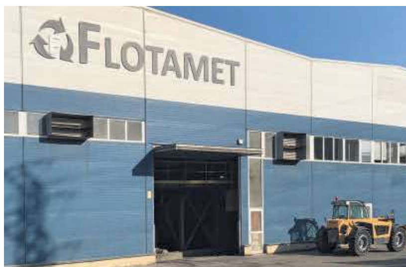
Instalaciones de Flotamet en la localidad de Elorrio.
